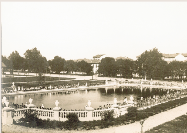
PISCINA DEL PARCO TROTTER
