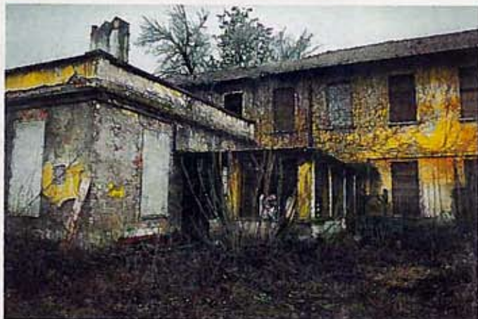
Ruderi Gli edifici fatiscenti del parco Trotter di via Padova (foto Marfisi)
